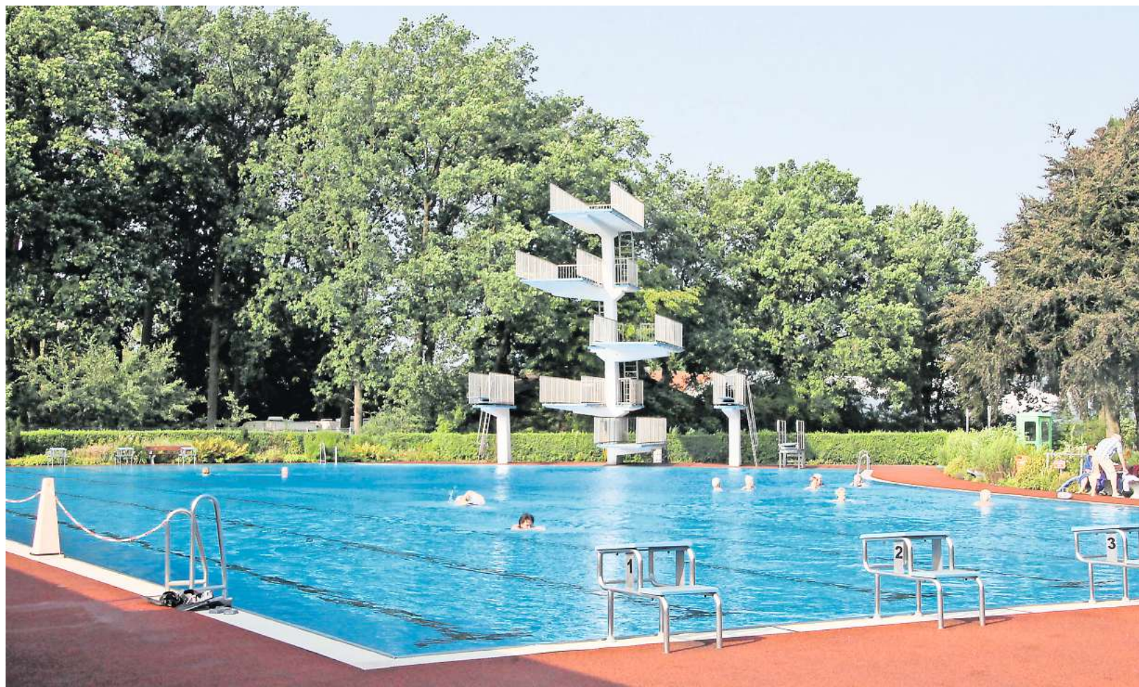
Das Schwimmerbecken im Hänigser Freibad soll saniert werden.
