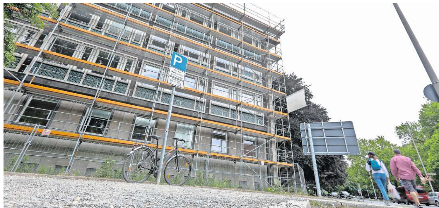
Seit 2012 eingerüstet – am Ende der Sanierung werden es elf Jahre sein: Das Bauamt neben dem Rathaus.
