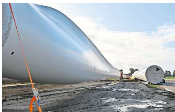
An den künftigen Standorten der Windräder lagern bereits die ersten Segmente.
