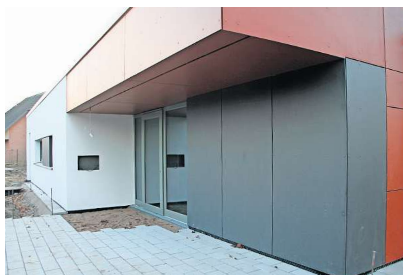
Der Bereich vor dem Eingang der neuen Kindertagesstätte wird bereits gepflastert.
